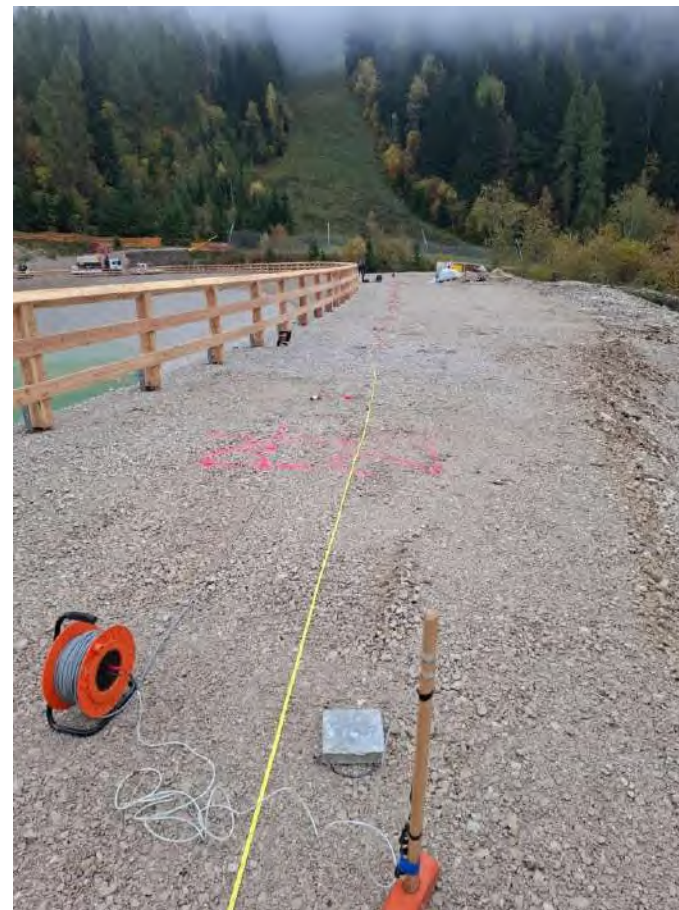
Foto 2: Stendimento sismico tomografico SR2
