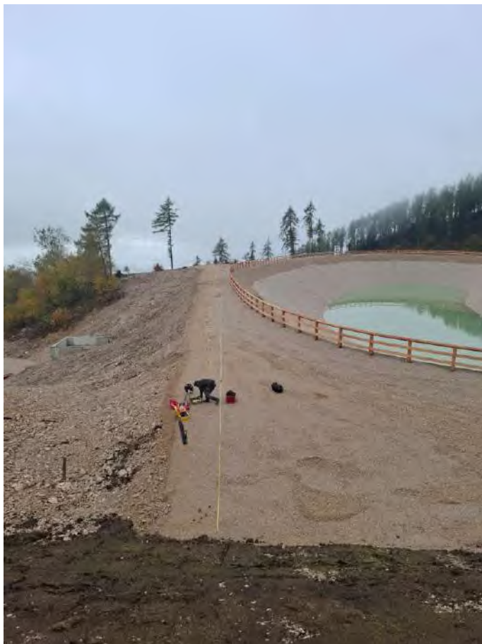
Foto 1: Stendimento sismico tomografico SR1
