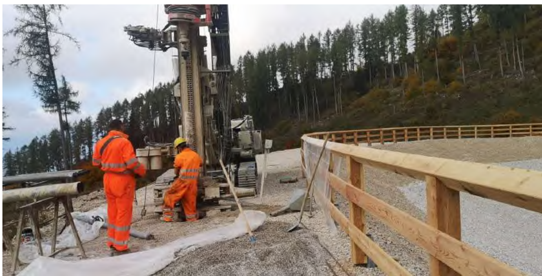
Posa del piezometro 4
